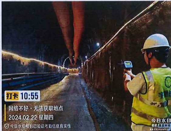
主干线隧洞段 3#支洞 350 米处
