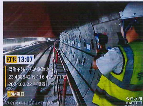
TBM 隧道洞口开端 300 米处
