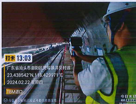
TBM 隧道洞口开端 250 米处
